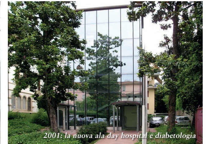
Lavori di ampliamento diabetologia
